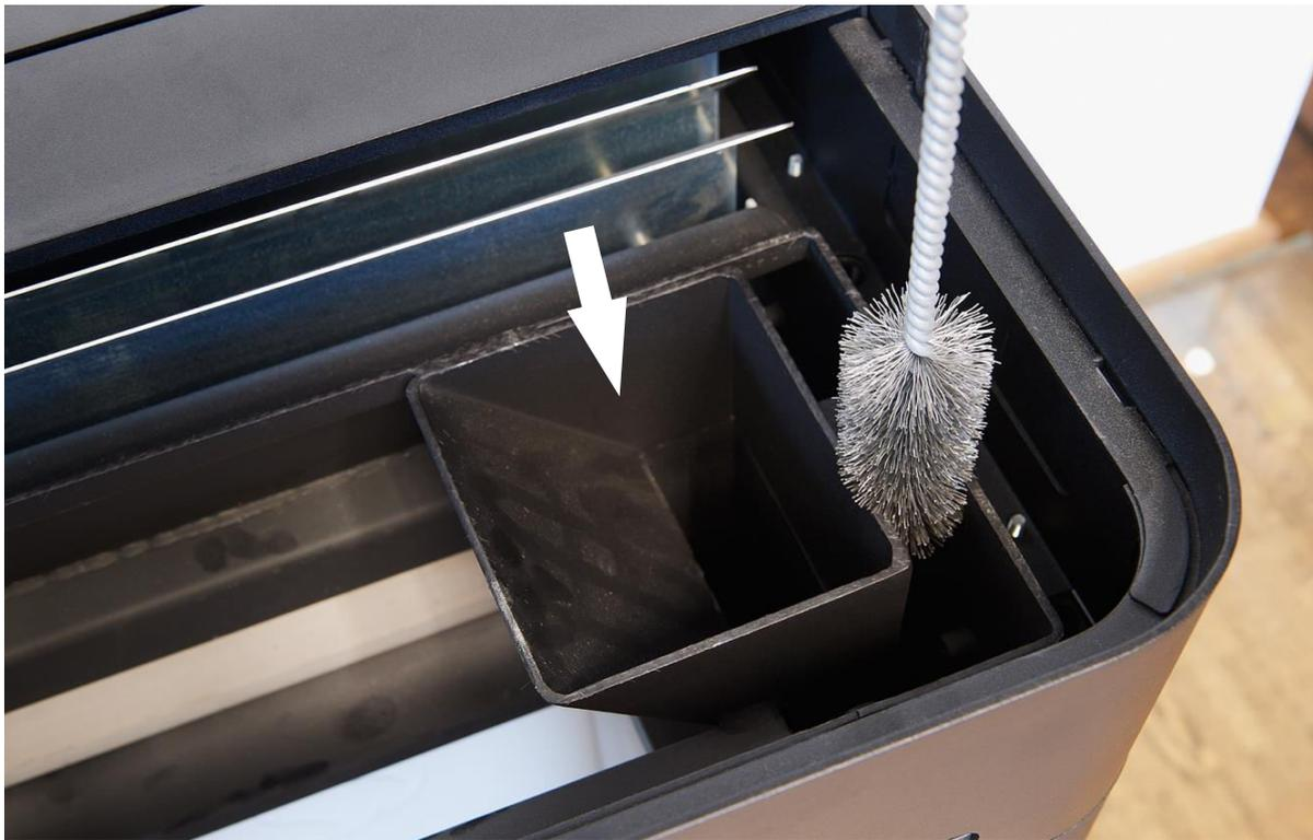
*Rauchgaszüge von oben, diese sind zu reinigen*
